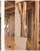
筋交い・外装材損傷
