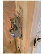
ホールダウン金物損傷
